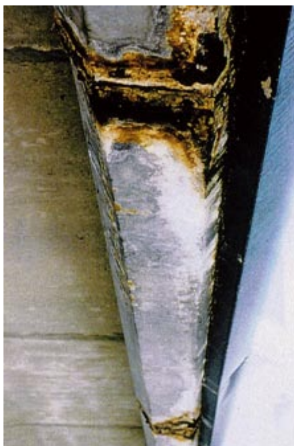
Photo 1 : corniche-caniveau dégradée
