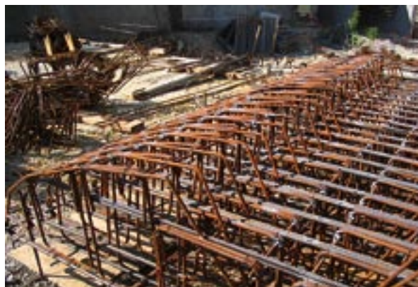
Photo 9 : cage d'armature d'une levée de pylône (ratio d'acier : 137 kg/m 3 )
