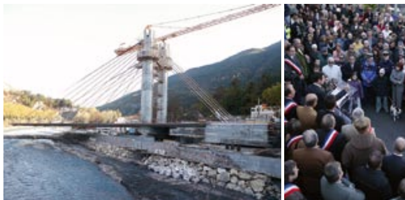
Photos 13 : la rotation de l'ouvrage
