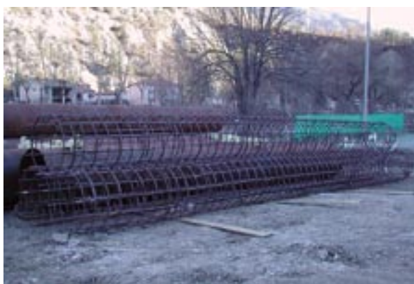
a) cages d'armatures
