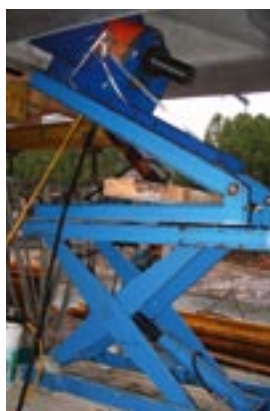
Photos 12 : mise en tension des haubans avant rotation depuis la sous-face du tablier
