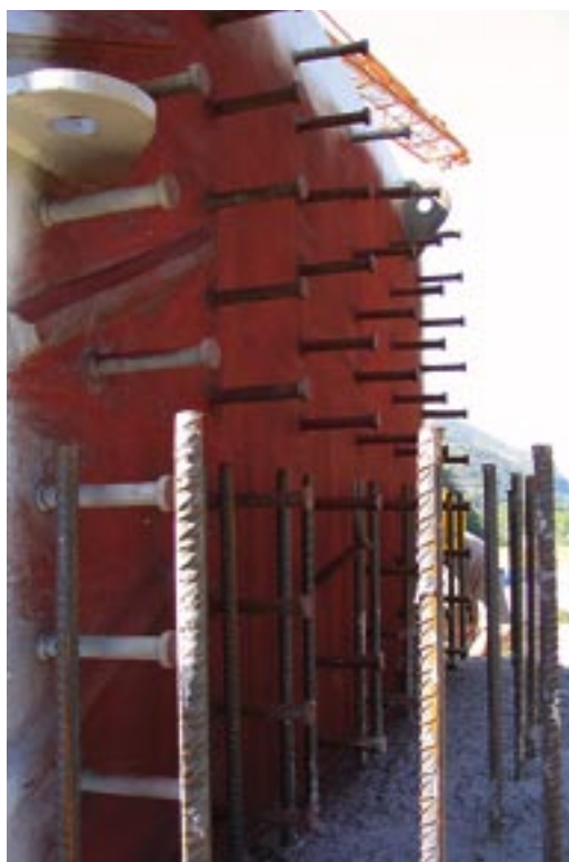
Photos 10 : boîtes d'ancrage métalliques des haubans
