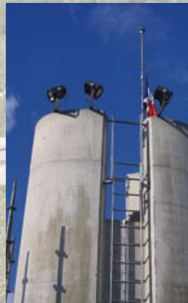
d) paratonnerre et éclairage en tête de mâts
