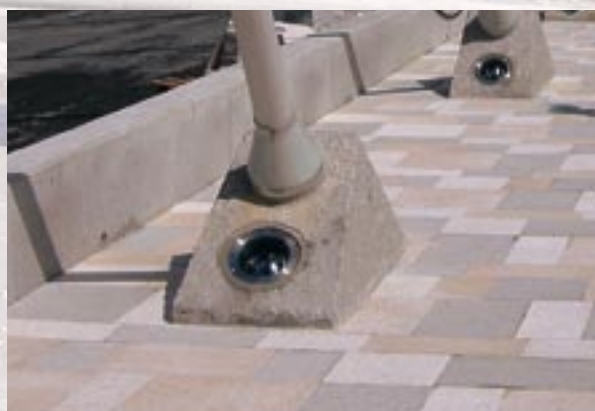
f) spots d'éclairage des haubans de retenue
