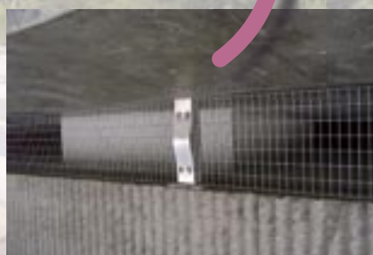
Photos 15 : butée parasismique de blocage latéral en culée rive gauche et grillage anti-intrusion
