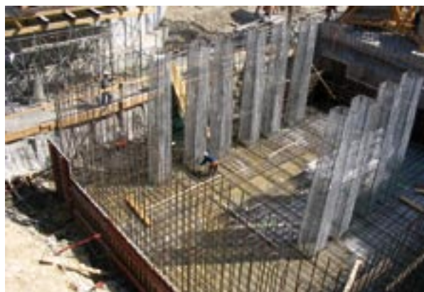
b) ferraillage et réservations pour les cheminées de solidarisation (mai 2004)
