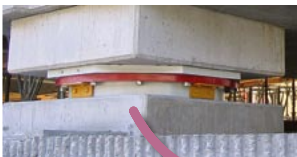
Photos 4 : positionnement de l'entretoise sous pylône avant rotation et détail de la couronne de guidage
