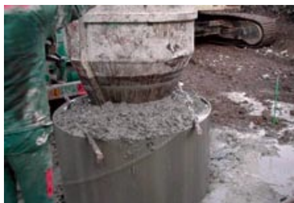
b) gaine métallique et bétonnage
