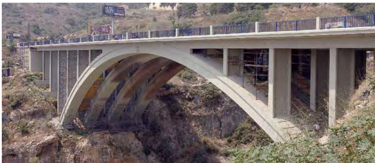
Photos 20, 21 et 22 : vues de l'ouvrage terminé – Source : Jean-Pierre Buys (Freyssinet)
