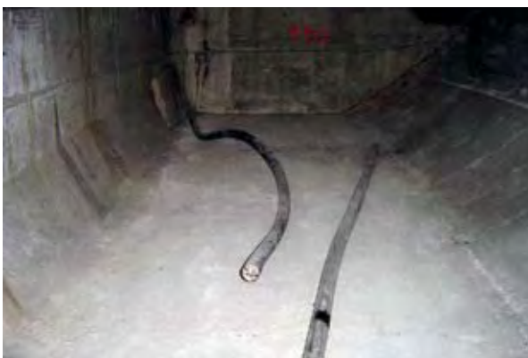
Photos 4 : câble rompu dans le viaduc de Saint-Cloud ; épluchage de la gaine au passage du déviateur – Source : RST
