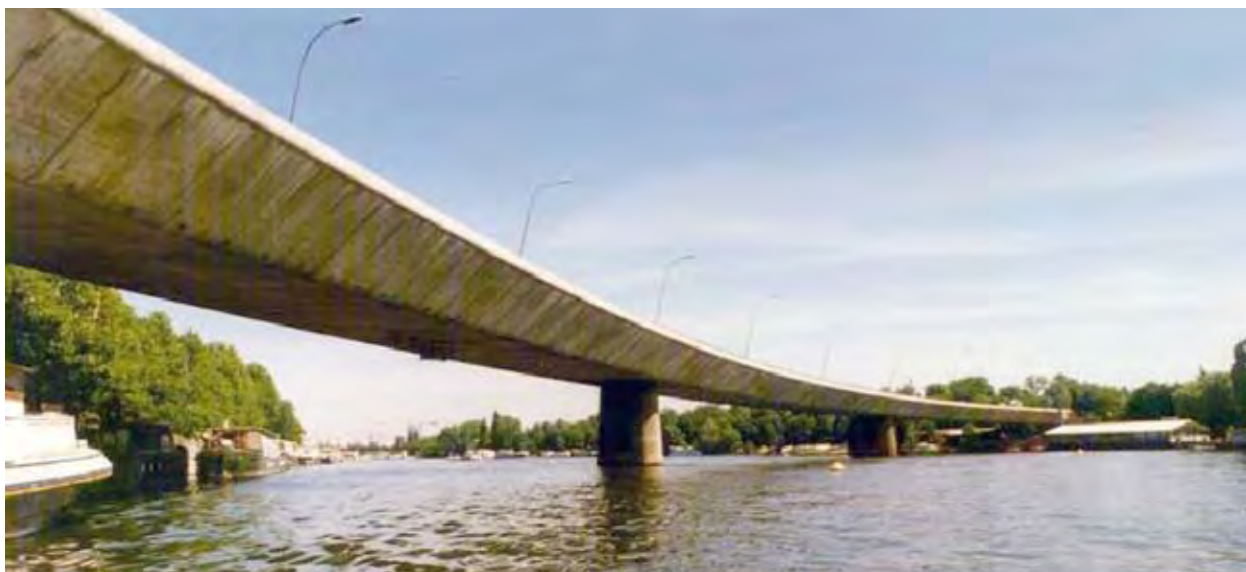
Photo 1 : vue générale du viaduc – Source : Sétra
