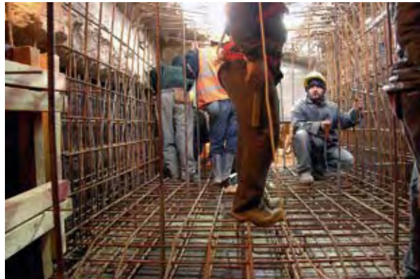
Photo 9 : mise en place du ferrailage à la clé de l'arc 2 – Source : Jean-Pierre Buys (Freysinet)
