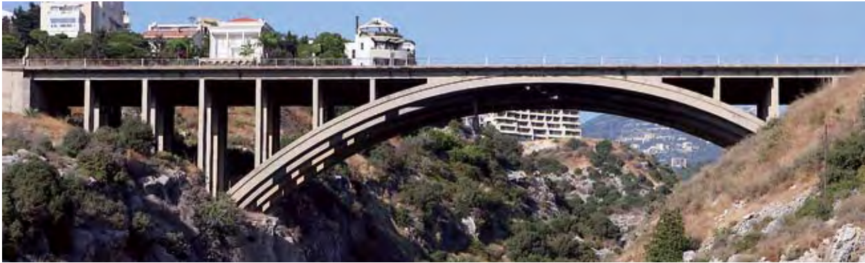
Photo 1 : vue du pont depuis l'aval – Source : Antoine Salamé (Gicome)
