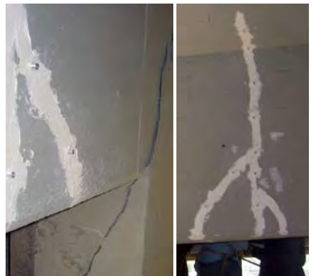
Photos 19a et 19b : injection des fissures – Source : Philippe Vion (Sétra)
