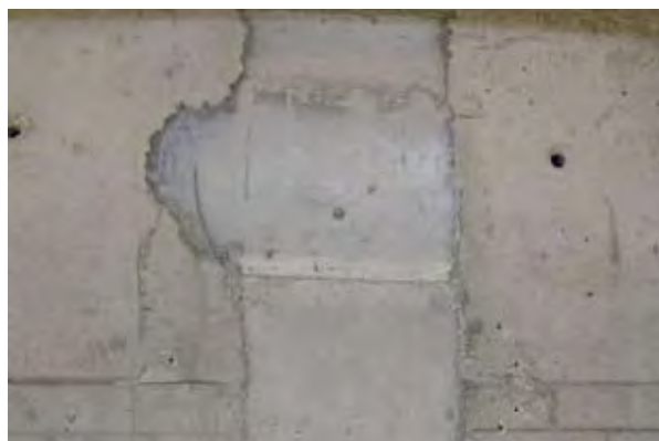
Photo 11 : joint de clavage bétonné – Source : Jean-Pierre Buys (Freysinet)
