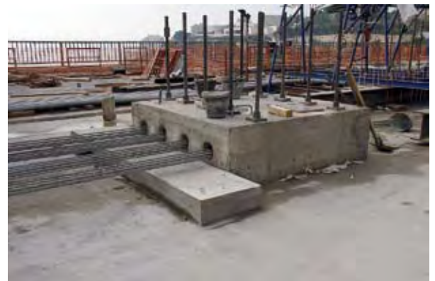
Photo 7 : massif de liaison avec le tablier et barres de précontrainte (côté Beyrouth) – Source : Jean-Pierre Buys (Freyssinet)
