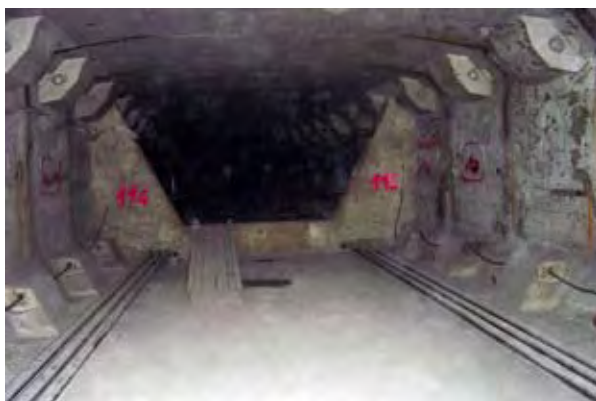
Photos 2 : intérieur du viaduc avec la précontrainte additionnelle – Source : Pascal Charles (Sétra)
