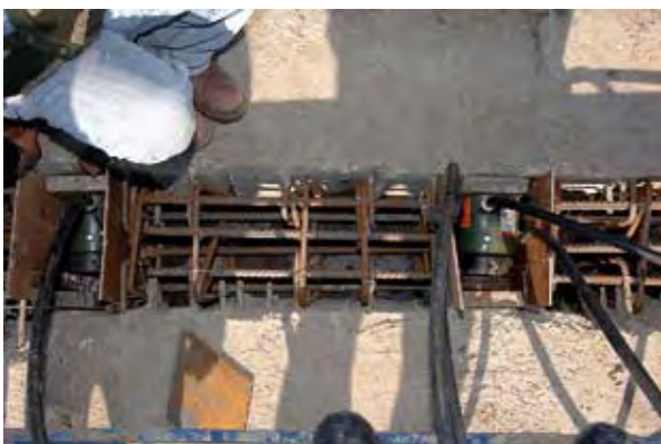
Photo 10 : vérins au niveau du hourdis inférieur Source : Jean-Pierre Buys (Freysinet)
