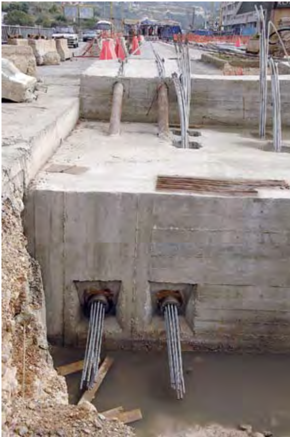
Photo 5 : massif d'ancrage arrière et bloc déviateur Source : Jean-Pierre Buys (Freyssinet)
