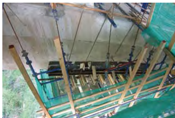
Photo 13 : plate-forme sous e'4 – Source : Philippe Vion (Sétra)
