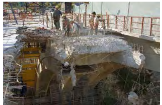
Photo 17 : démolition de l'arc 3 – Source : Jean-Pierre Buys (Freysinet)
