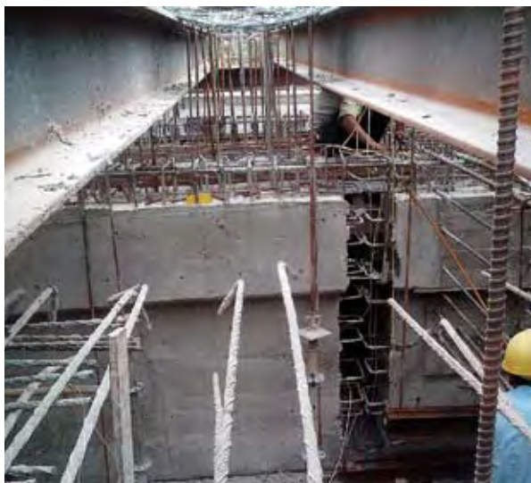
Photo 18 : joint de clavage de l'arc 3 – Source : Jean-Pierre Buys (Freysinet)
