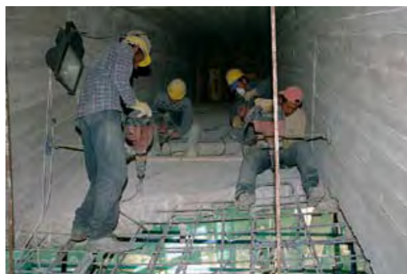
Photo 14 : démolition du hourdis inférieur Source : Jean-Pierre Buys (Freyssinet)
