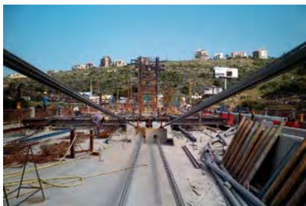
Photo 15 : massifs de liaison et précontrainte de sécurité Source : Jean-Pierre Buys (Freyssinet)
