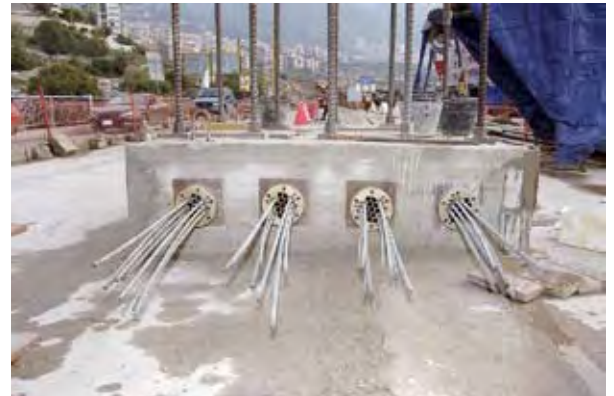
Photo 6 : massif de liaison avec le tablier Source : Jean-Pierre Buys (Freyssinet)
