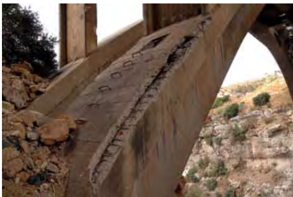
Photos 4a et 4b : désordres du hourdis supérieur de l'arc 3 côté Beyrouth (extérieur et intérieur) – Source : Jean-Pierre Buys (Freyssinet)
