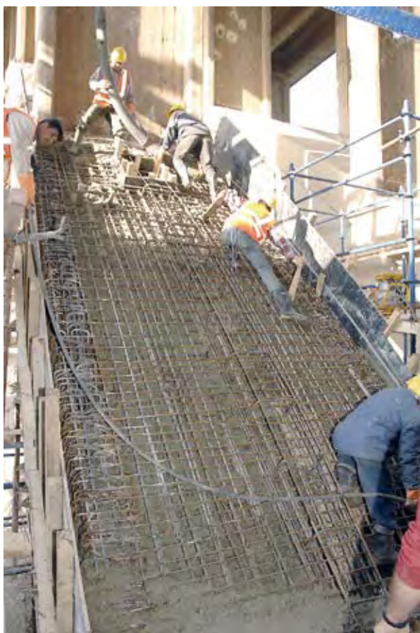
Photo 12 : bétonnage du hourdis supérieur de l'arc 3 Source : Jean-Pierre Buys (Freyssinet)
