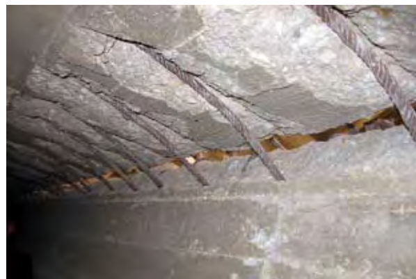
Photos 4a et 4b : désordres du hourdis supérieur de l'arc 3 côté Beyrouth (extérieur et intérieur) – Source : Jean-Pierre Buys (Freyssinet)
