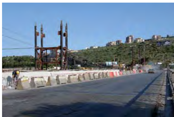
Photo 16 : pylône et précontrainte extradossée Source : Jean-Pierre Buys (Freyssinet)
