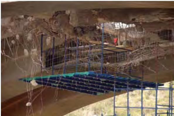
Photo 8 : mise en place des plates-formes Source : Jean-Pierre Buys (Freysinet)
