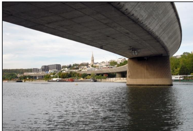
Figure 1 : Viaduc de Saint-Cloud (Crédit photo H. Delahousse, Ifsttar).
