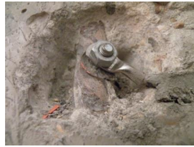
Connexion à l'armature
