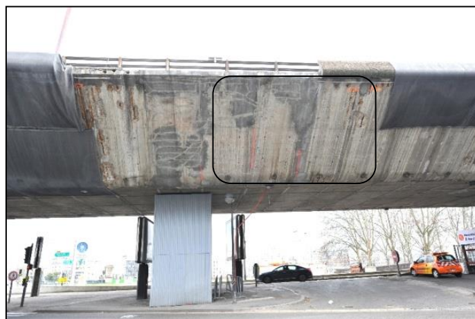
Figure 8 : Voussoirs de la planche d'essai pilote (voussoir sur pile P2 et voussoirs courants P2-1 et P2-2 côté Saint-Cloud).
