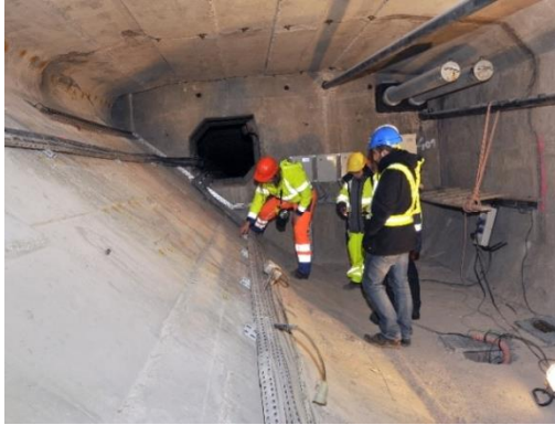
Intérieur du voussoir (Pile P2)
