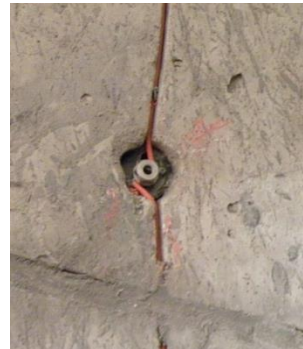
Connexion de l'anode noyée
