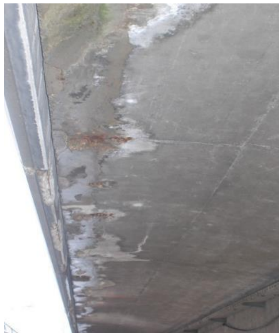
Figure 5. Circulation d'eau sous les encorbellements
