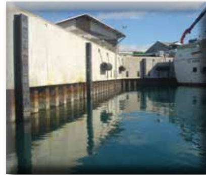
Inspection d'ouvrages maritimes
