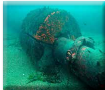
Inspection de canalisations immergées
